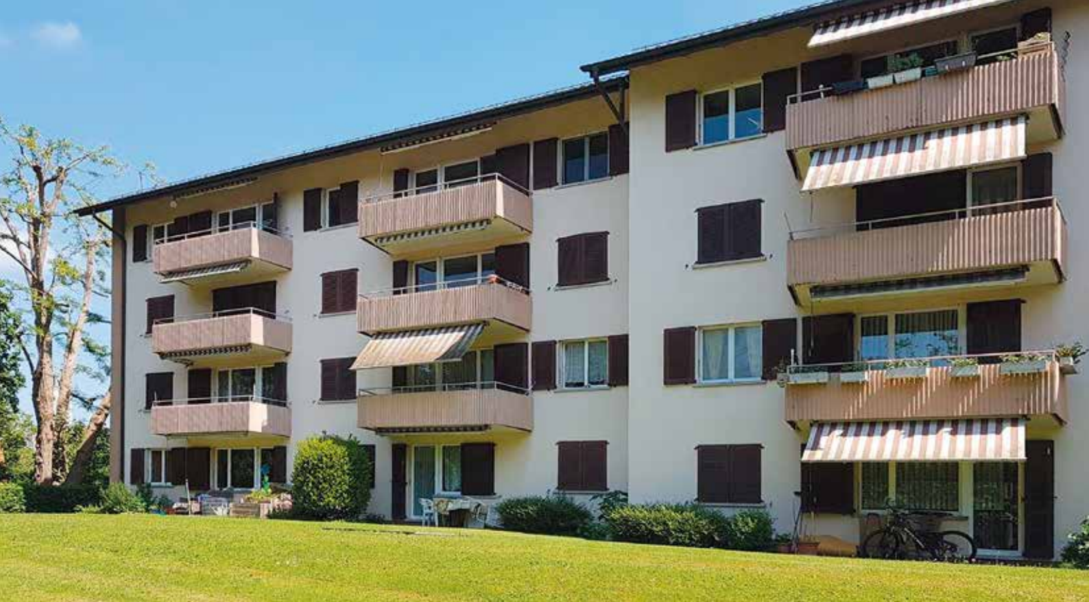
Aus alt wird neu: Eines der Mehrfamilienhäuser an der Reiserstrasse in Olten vor und nach der Sanierung. Unter anderem wurden Fassaden, Balkone sowie die Gartenumgebung aufgefrischt und neu gestaltet.
