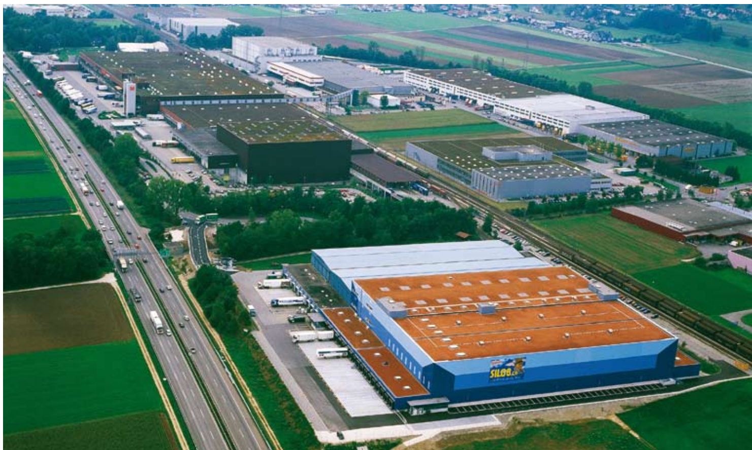
Die Migros-Verteilbetrieb Neuendorf AG ist sozusagen das «Herz» des Logistic-Valley Gäu. Die Lagerräumlichkeiten der MVN sind auf einer Fläche von 236'000 m 2 zusammengefasst.
