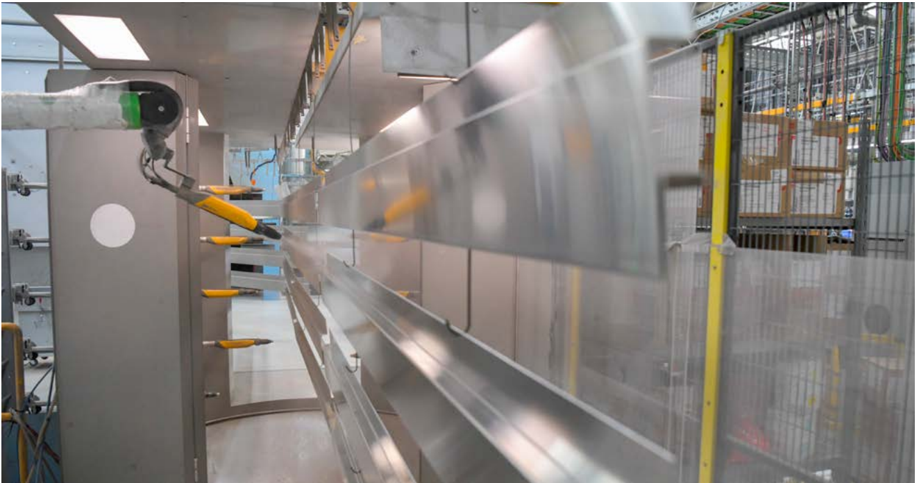
Pulverbeschichten auf dem Karussellroboter
